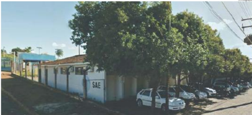
Sede da Superintendência Municipal de Água e Esgoto de Catalão
